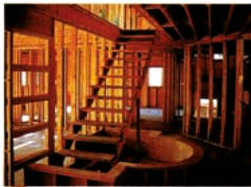
Les escaliers sont en orme, hêtre ou platane ; les planchers et les plinthes en pin maritime, chêne ou châtaignier et la charpente
